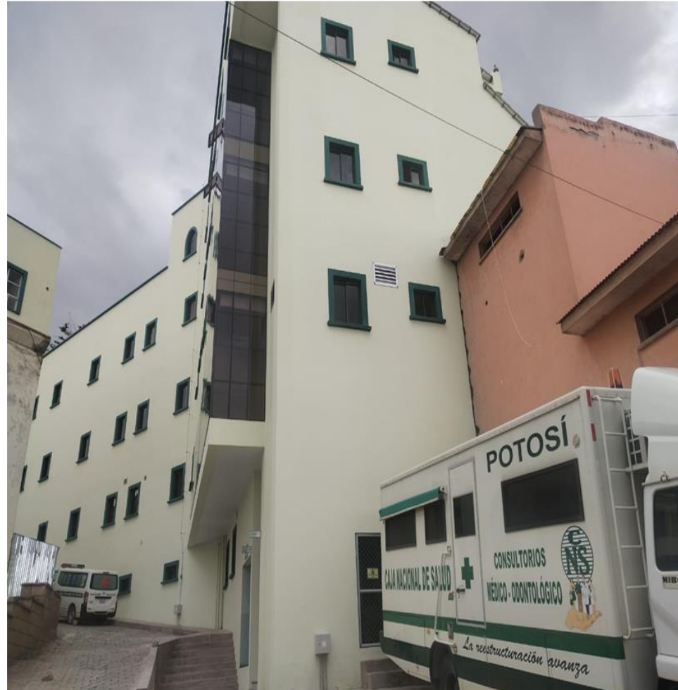
Fotografías 1: Vistas de fachadas.
